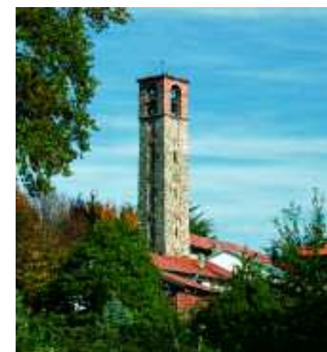
La Chiesa di San Giorgio a Cagno
