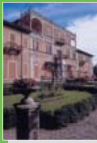
Gazzada Schianno: Villa Cagnola
